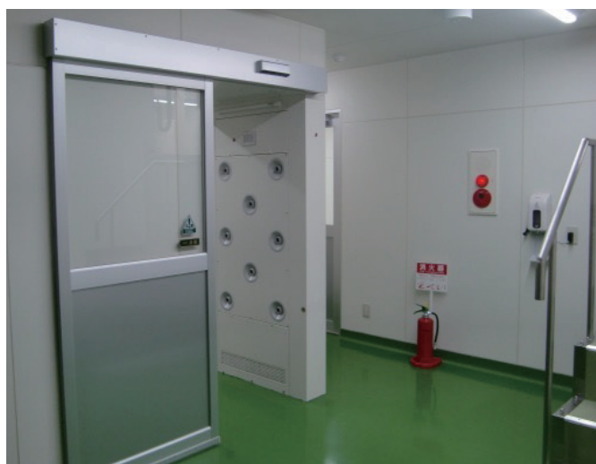
エアシャワー製作設置(自動ドア)
