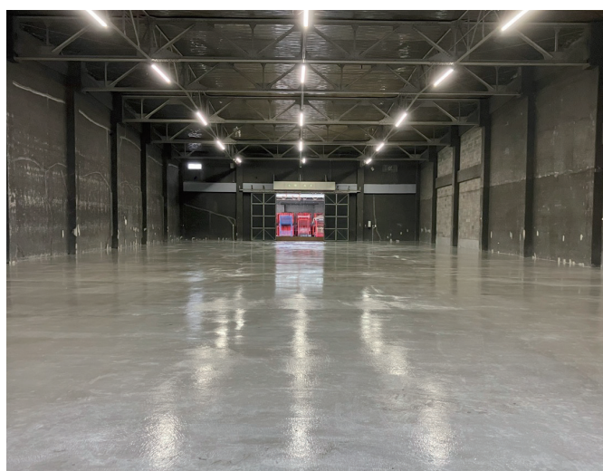
倉庫床打ち直し
