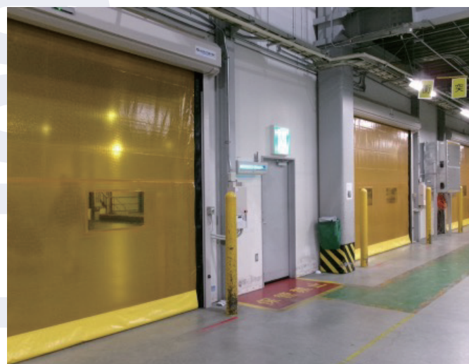
シートシャッター更新
